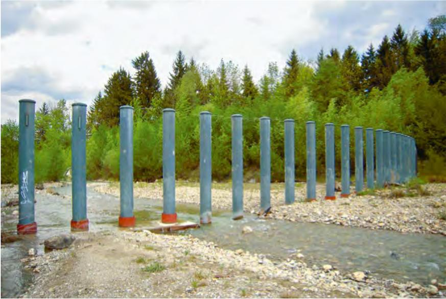
**Abb. 5.11: Holzrückhalterechen am Ende der Ausschütte, Wattenwil.**
