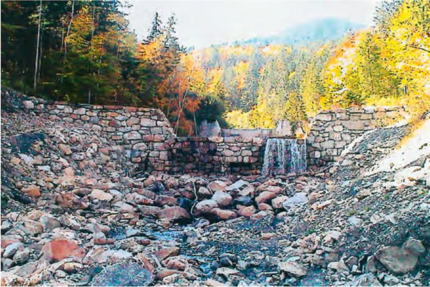
**Abb. 5.13: Fertig gestellte Bergamasker-Sperre (Sperrung 9), 1999.**
